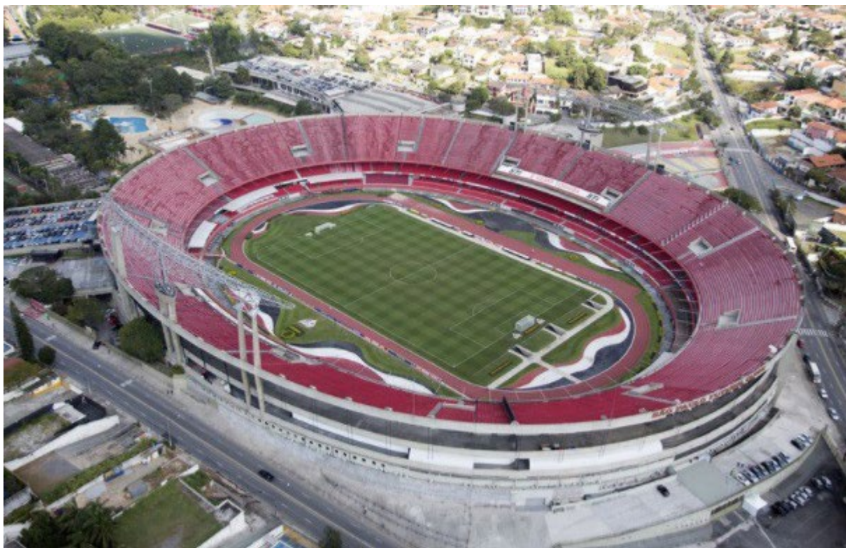
Estádio do Morumbi. ( http://www.saopaulofc.net/estrutura/morumbi/sobre-o-morumbi/ )
