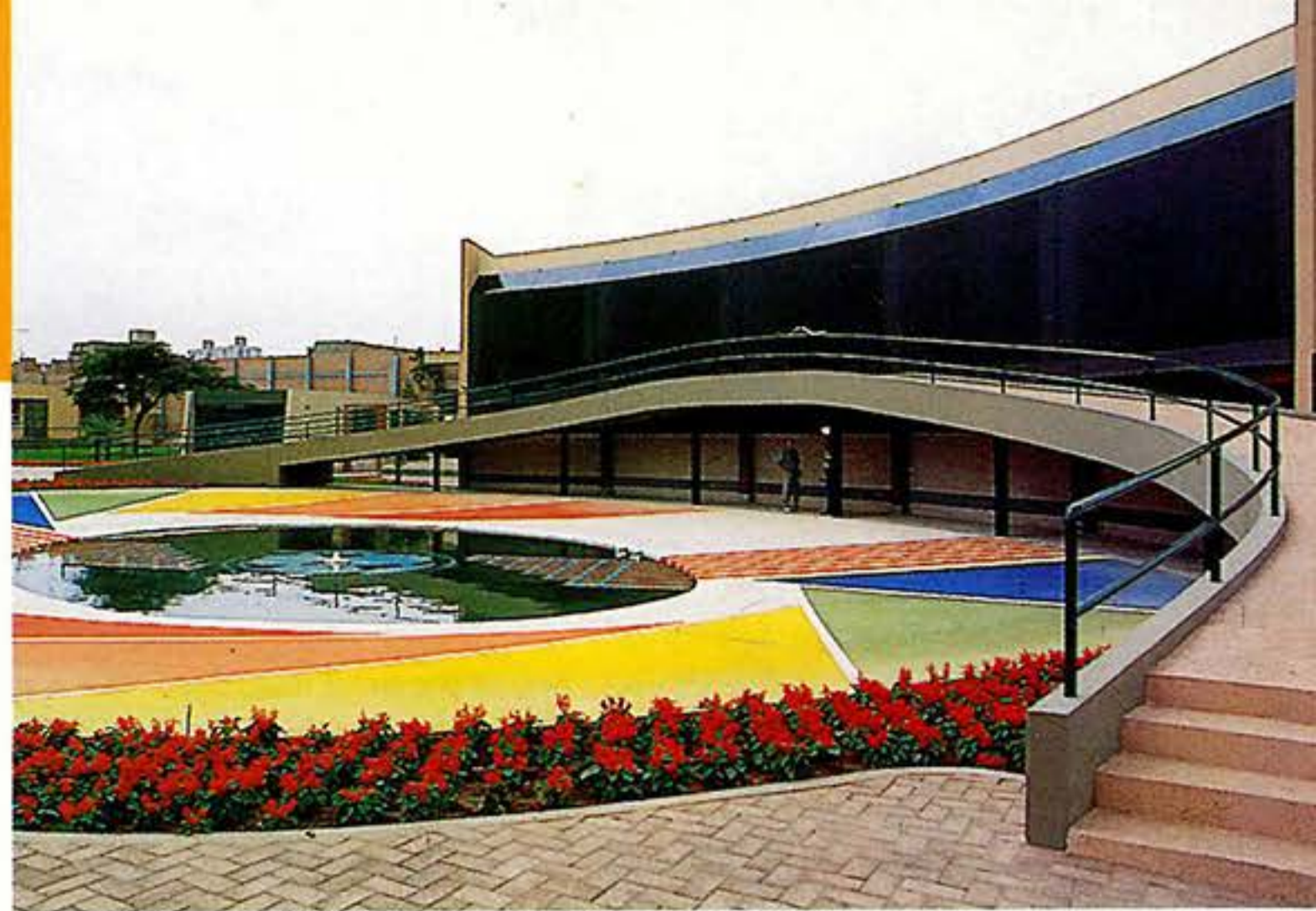
Fachada del edificio de oficinas que, desde septiembre, es la sede de la Federación.
