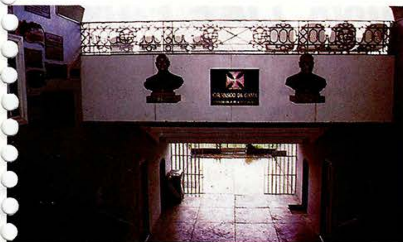
Otra vista del estadio São Januário, que fue construido mediante una colecta popular e inaugurado en 1927. Después del Maracanã, es el más grande de Río. Another view of the São Januário Stadium that was built thanks to a popular collection and inaugurated in 1927. It is the largest of Río after Maracanã.
