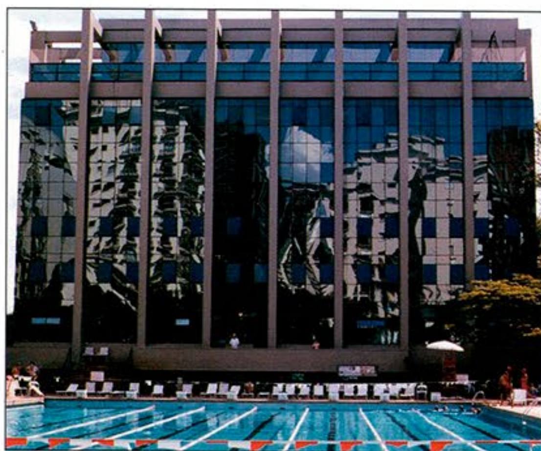
Prédio Novo após reforma, 1997
