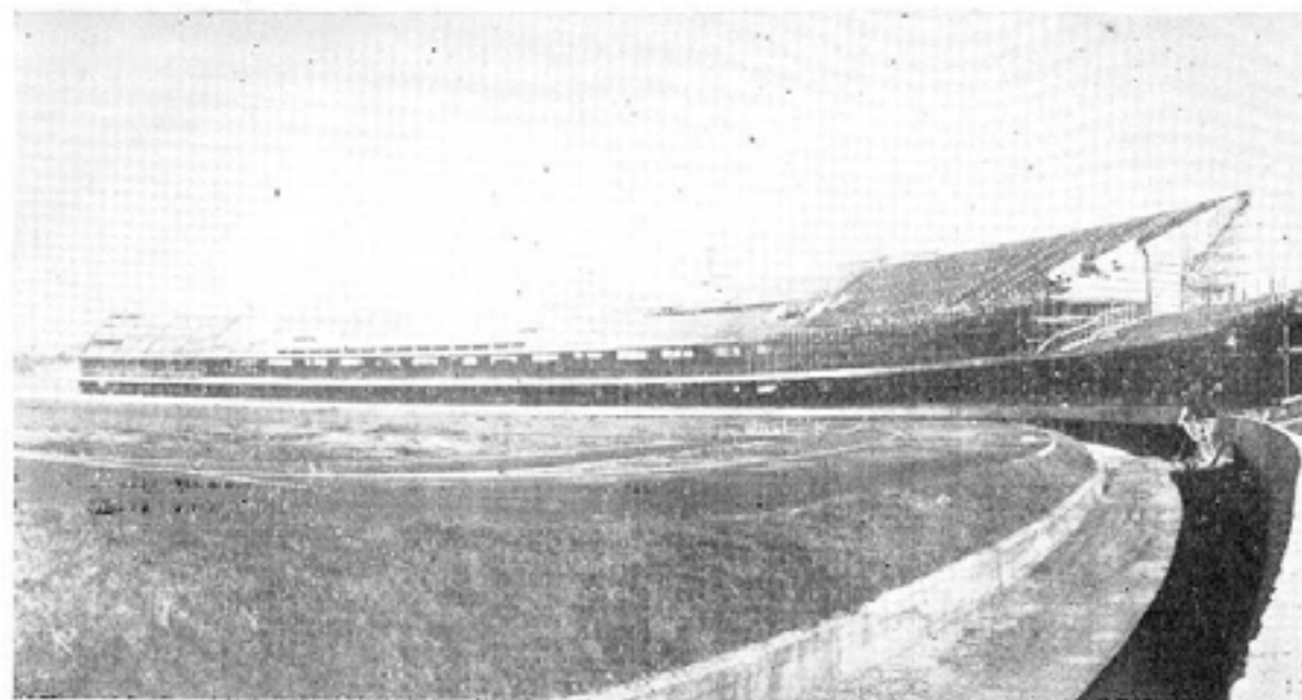
Aspecto das obras em fins de 1958
