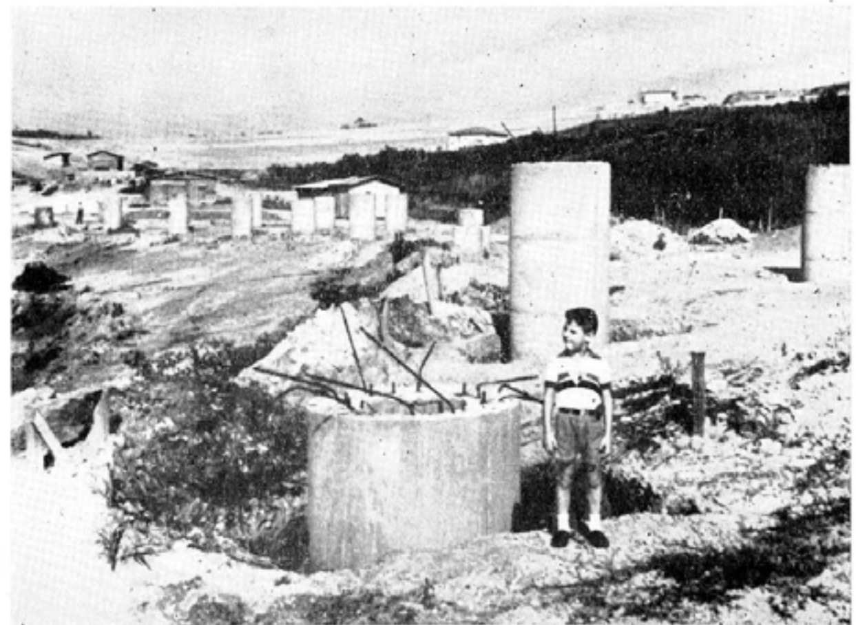
...e os primeiros tubulões das fundações também
