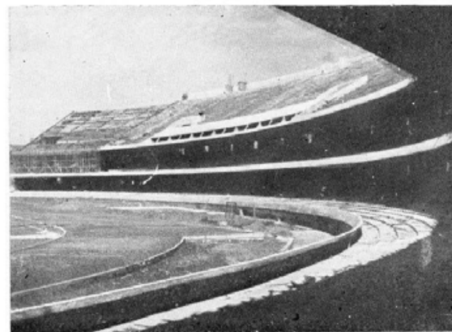
Detalhe dos lances superiores de arribancadas
