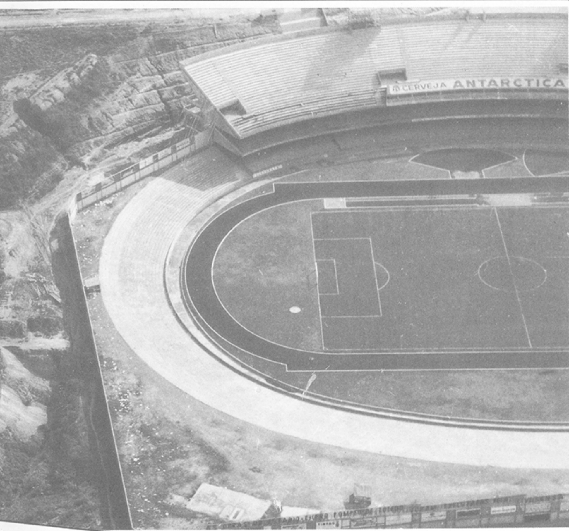
Vários estágios da construção do Morumbi: as piscinas em abril de 61 (esquerda, ao alto) e em novembro do mesmo ano (ao lado); e o fechamento do anel em 69 (esquerda, embaixo).
